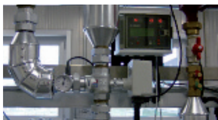
MISCELATORE ELETTRONICO con disinfezione termica programmabile e verifica disinfezione. Attacchi filettati o flangiati. (Caleffi, serie 6000 LEGIOMIX®)
