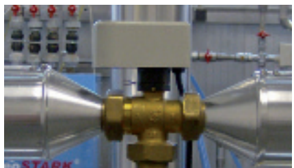
VALVOLA A SFERA a tre vie deviatrice motorizzata. Completa di motore con comando a 3 contatti. Con microinterruttore ausiliario. (Caleffi, serie 6443)
